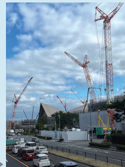
リニューアル工事▶
